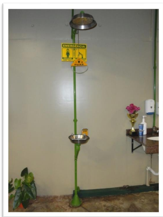
Figura 18: Chuveiro e lava-olhos para situações de emergência
